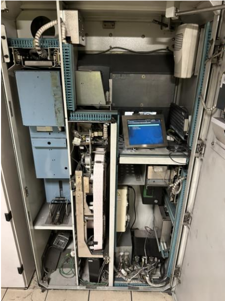
Figure 17: Ceci est l'intérieur d'un DAT
