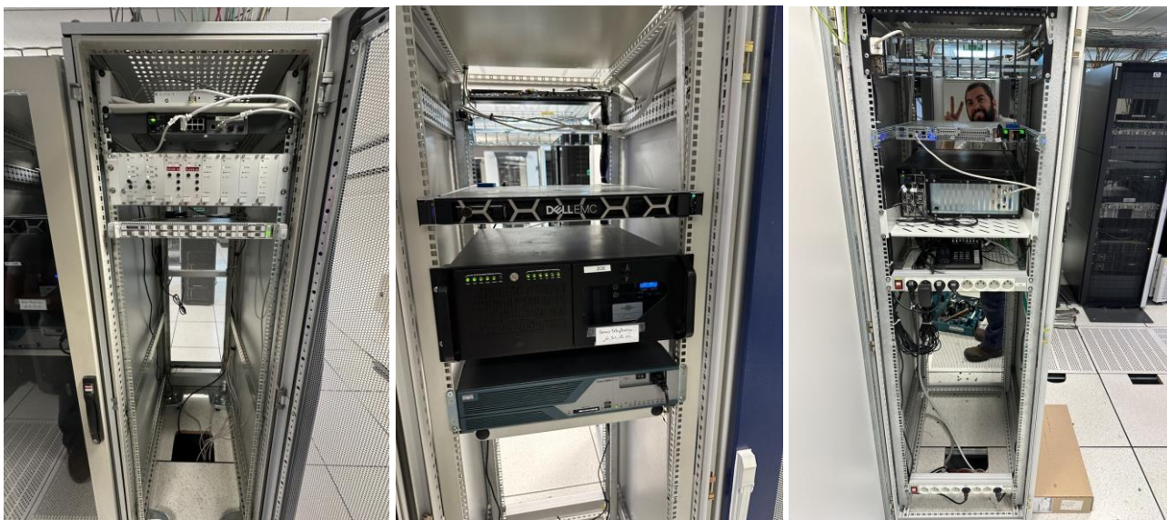
Figure 7 : Baies après déplacement
