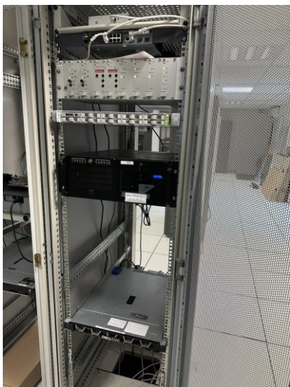
Figure 6 : Baie avant déplacement
